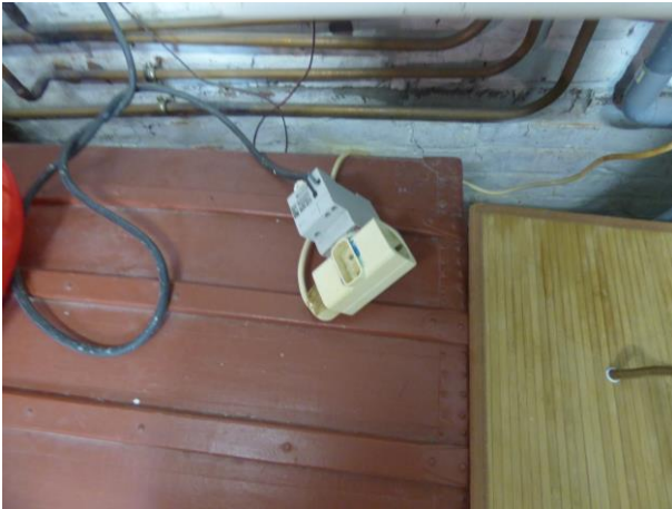
Matériel pas en place
