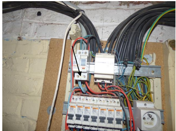
Revoir l'alimentation de la dernière rampe du tableau (connexion depuis le dessous du 30 mA)
