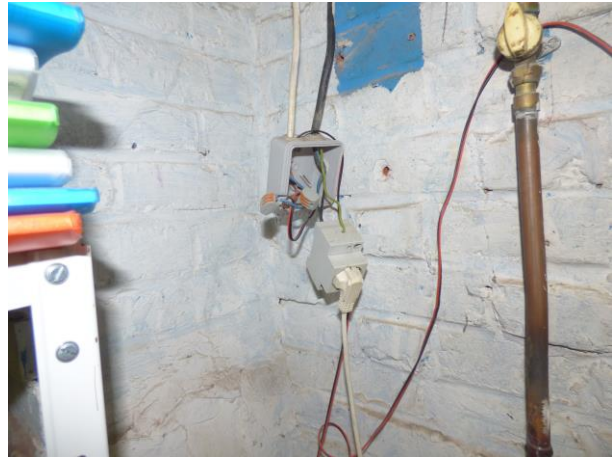
Matériel pas en place
