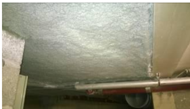
R-1 Chaufferie Prélèvement P001 FLOCAGE SANS AMIANTE
