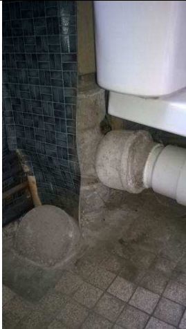
IV 1: 5 Avenue Gambetta - LAON - 1er étage - 10 - Conduit évacuation des WC - Photo n° 1
