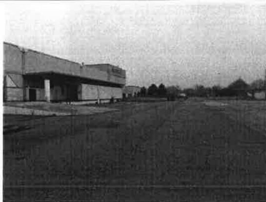
Absence de produits dangereux et de déchets à l'entrée du site (côté face à la voirie)
