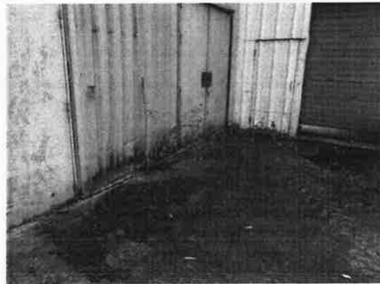
Absence de produits dangereux et de déchets (côté arrière de l'usine)
