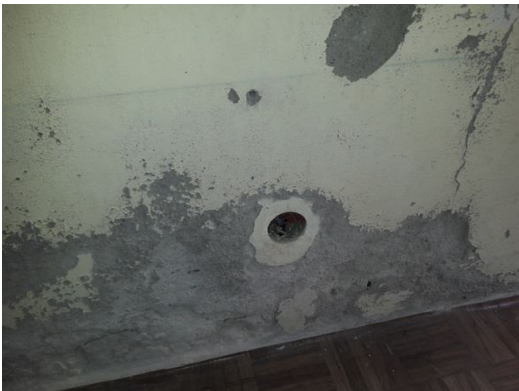
Connexions nues sous tension (Cellier,Grenier1,Grenier4,Grenier6,Cave sousEscalier,Bureau3,Bureau4,Chaufferie,Pièce1,Pièce4)
