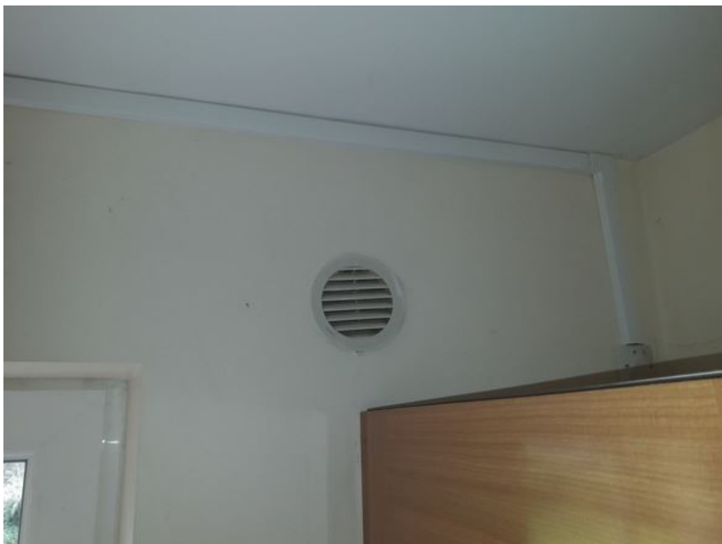
L'amenée d'air n'est pas directe alors que la sortie d'air est directe
