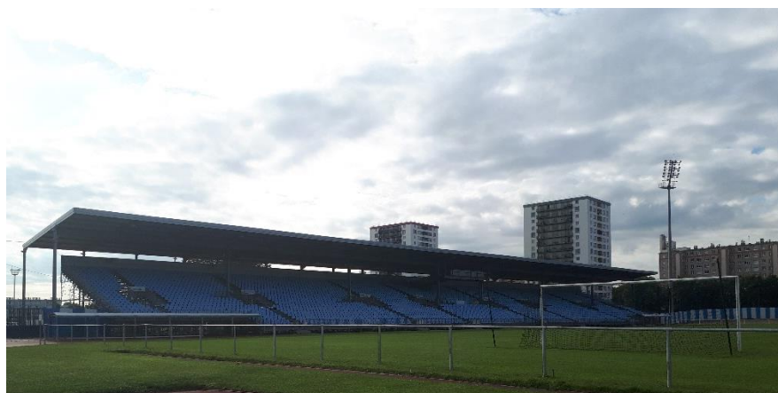
Figure 1 - Vue général de la tribune
